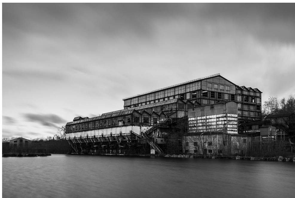
De haut en bas Recette du puits central, bassin houiller d'Auvergne, Noyant-d'Allier (Allier) Lavoir des Chavannes, bassin houiller de Blanzky, Montceau-les-Mines (Saône-et-Loire) © Pascal Baudry - Centre Minier de Faymoreau
